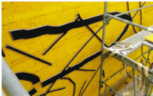
Positionierung der Grafik auf die Fassade und Übertragung im Sichtbeton mittels gelaserten Schalelementen
